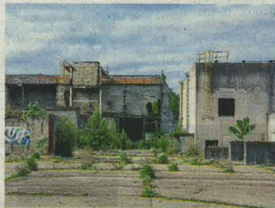
La friche Darbo, à Linxe (40), sera réhabilitée par le Groupe Essor, autour notamment d'une zone d'habitation, de locaux d'activité, d'une centrale photovoltaïque et de la renaturation d'un site de 10 hectares. © Brouillet
